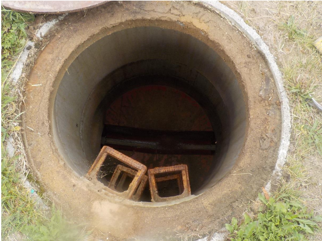
Eingebaute Kanalisation (1,00 – 1,20 m tief)
