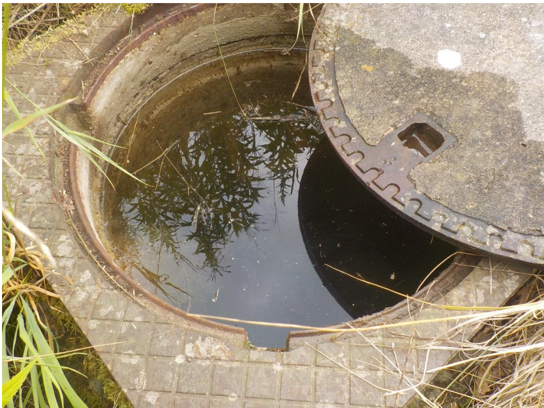
Wassergefüllter Anschlussschacht
