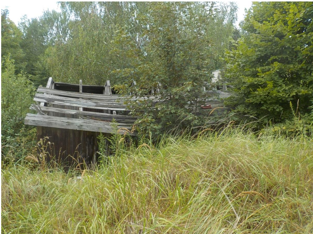
Bestehendes baufälliges Gebäude
